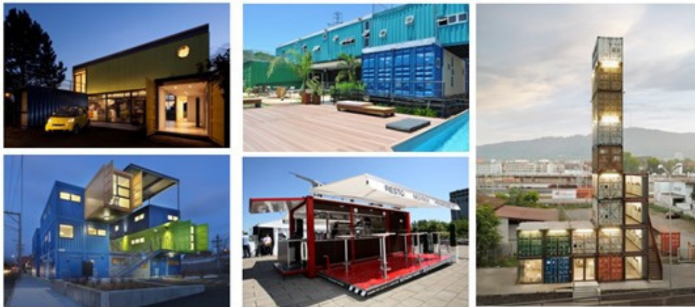
Figura 1 - Exemplos de aplicações para o contêiner marítimo na construção civil, em sentido horário a partir do canto superior esquerdo: Casa Container Granja Viana, Tetris Hostel, Freitag Flagship Zurich, Muv Box Fastfood Container Restaurant, The Box Office.
