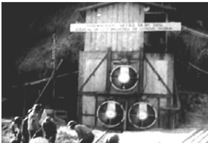
Figura 2. Instalação dos ventiladores no ensaio preliminar.
