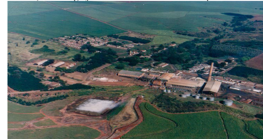
Foto 4 – Vista aérea da Usina Tamoio. A direita vê-se a usina e casas da sede. No centro, a (Vila Central) ao alto, vê-se a igreja de São Pedro e a direita a seção Mariza.
