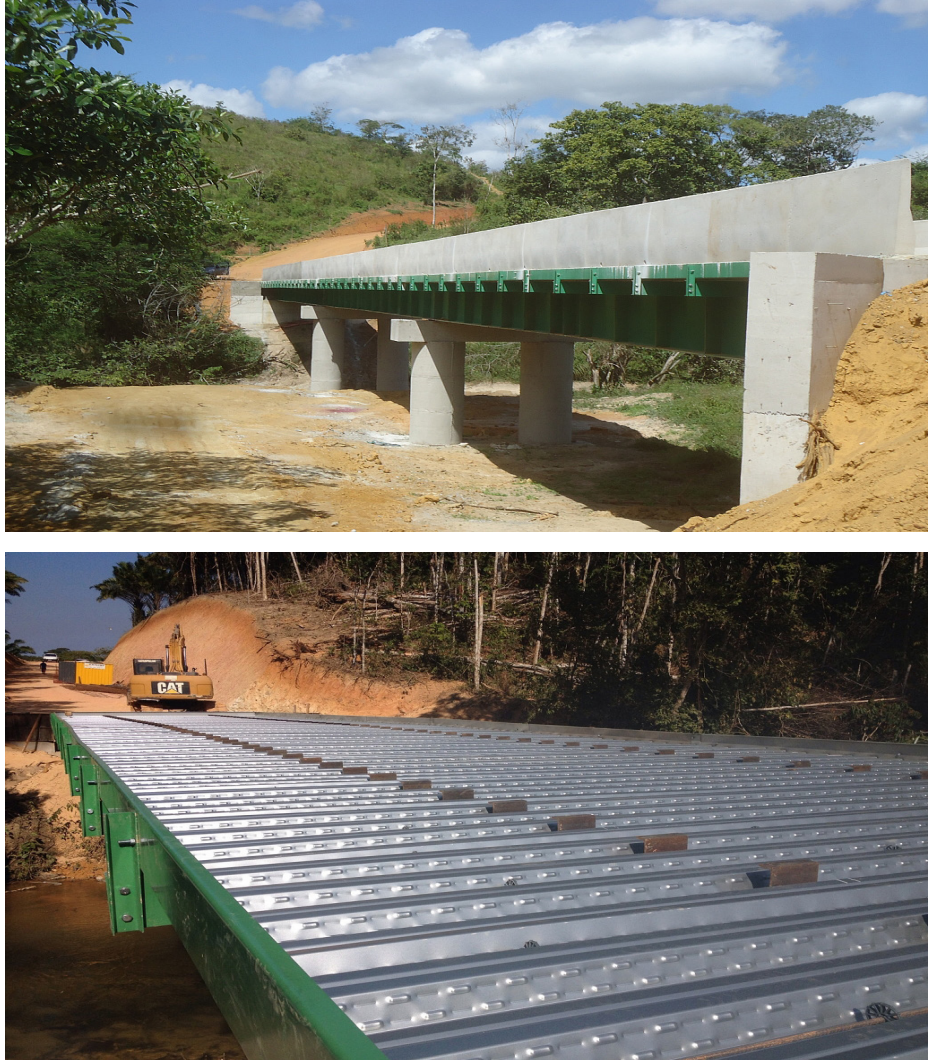
Figura 2 - Ponte mista de aço e concreto construída na zona rural de Eunápolis-BA.
