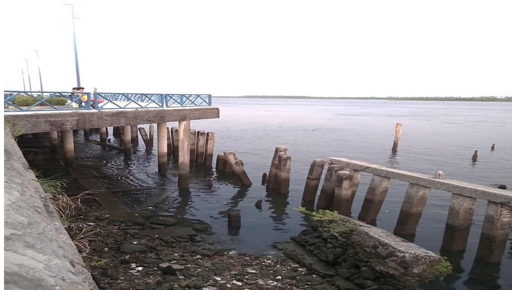
Figura 7 – A) Trapiche destruído por conta da erosão; B) Trapiche reconstruído.
