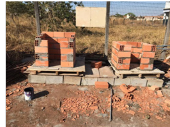
(a) Construção das paredes laterais
