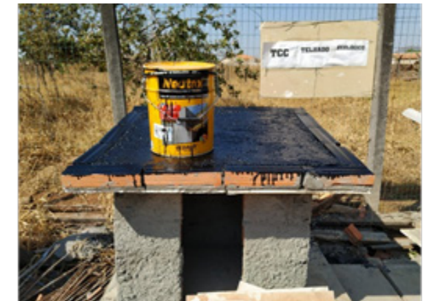
(b) Impermeabilização – Etapa 1
