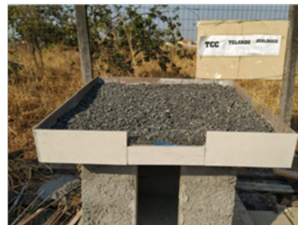
(c) Drenagem – Etapa 2
