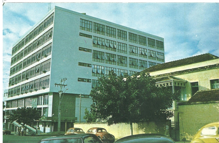
Figura 3 - Edifício sede do Centro de Treinamento da ECT de Bauru/SP.
